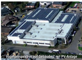
Vogelperspektive auf Gebäude 2 mit PV-Anlage
